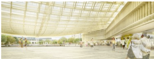
© Berger et Anziutti / L'Autre Image La structure des ailes latérales est constituée de portiques. Au centre, quinze poutres transversales cintrées reposent sur des poutres de rives en "U"
